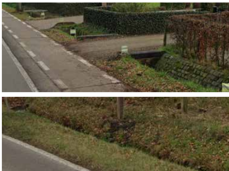
Figuur 7-18 : Baangracht in de Bevelse Steenweg, als voorbeeld voor de willekeur waarop de inrichting ervan in dezelfde straat gebeurt. Boven: deels ingebuisd en deels open met verharde wanden (en bodem); onder: gracht als een blauwgroene as langs de straat.
