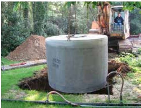
Figuur 7-27 : Het plaatsen van een hemelwaterput voor het opvangen en hergebruiken van hemelwater
