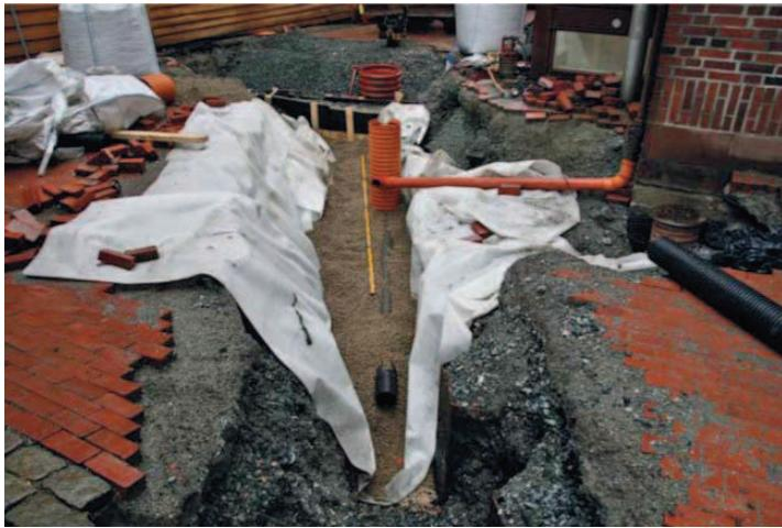
**FIGURE 4. CONSTRUCTION OF SUBSURFACE INFILTRATION SYSTEM
