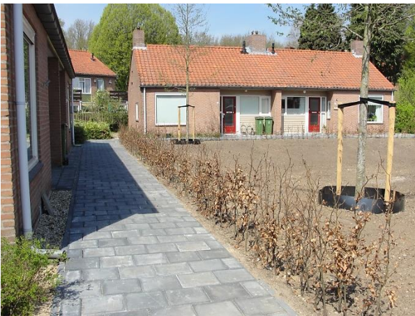
Regenpijp voorzijde woningen voert af via stoep naar wadi (foto's Kees Broks)
