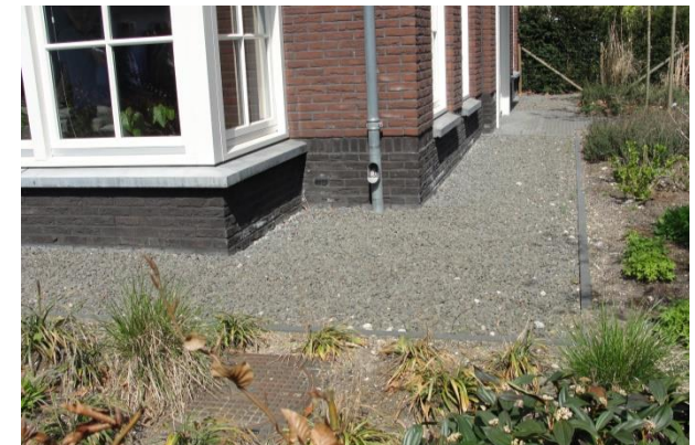
Infiltratieput op particulier terrein (onder putdeksel), dakafvoer met bladafscheider (foto's Antal Zuurman (L) en Kees Broks (R))
