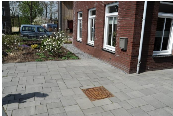
Infiltratieput op particulier terrein (onder putdeksel), dakafvoer met bladafscheider (foto's Antal Zuurman (L) en Kees Broks (R))
