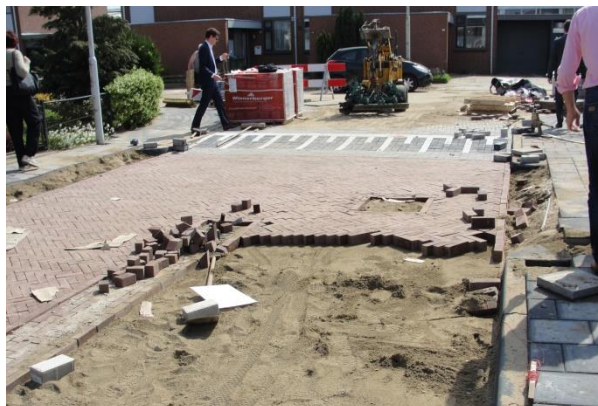
Instreamkolk/zandvang aan einde molgoot, met infiltratieput onder putdeksel (foto Kees Broks)
